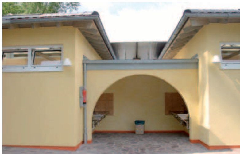
Über dem Rundbogen des neuen Sanitärgebäudes mit Platz für zehn Duschen, acht Waschtische und drei Spültische ist die Rückseite des Großflächenkolektors zu sehen.
