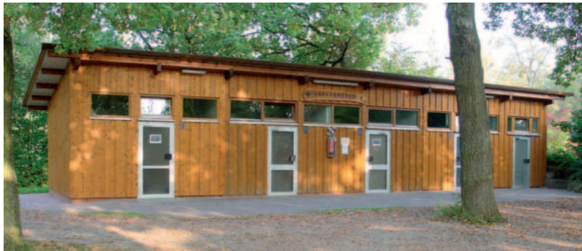
Das alte Sanitär-Gebäude im Camping- und Freizeitcenter Oberrhein (FCO) in Rheinmünster-Stollhofen wurde mit varmeco-Produkten umgebaut und grundsaniert, so dass dort den Gästen heute acht Duschen, neun Waschtische und drei Spültische zur Verfügung stehen.
