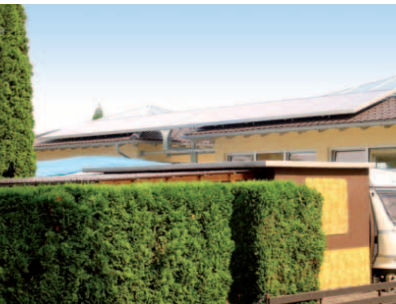
Die Rückseitenansicht zeigt die nebeneinander montierten Kollektoren AS 14 mit insgesamt 28 Quadratmetern Fläche, der mittig zu sehende Metalltrichter verdeckt die Anschlüsse.
