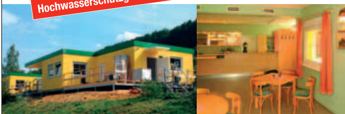
Abbildungen: Campingplatzanlage in Königstein an der Elbe. Die gesamte Anlage ist im Hochwasserfall innerhalb von 48 Stunden abzubauen und außerhalb der Hochwasserzone zwischen zu lagern.
