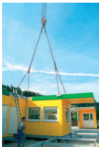
In neun Wochen Bauzeit im Werk wurde der größte Teil der Vorarbeiten erledigt.
