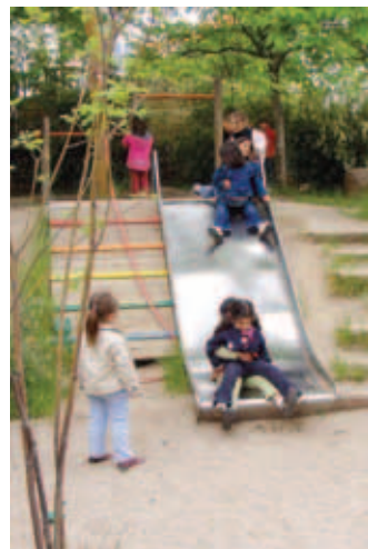
Rutschen – aber sicher! Da die Rutsche in den Hang eingebaut ist, können die Kleinen nicht seitlich herabstürzen. Die Holzbalken auf der rechten Seite bilden eine natürliche Treppe, links kann gefahrlos geklettert werden.
