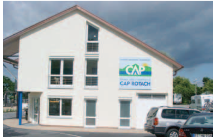
Rund 1,4 Mio. Euro kostete der barrierefreie Anbau, in dem Rezeption, Sanitäranlagen und Gästezimmer Platz finden.
